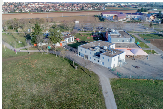
Installation d'une nouvelle zone de fitness au Parc de Loisirs.
